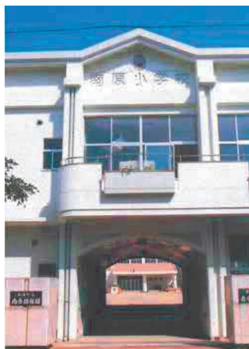
特別教室棟完成
